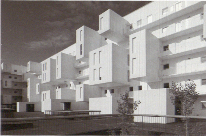
Dosmasuno arquitectos Ignacio Borrego, Néstor Montenegro y Lina Toro
